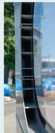
図5 窓枠付近にはハモニカ断面を使用
